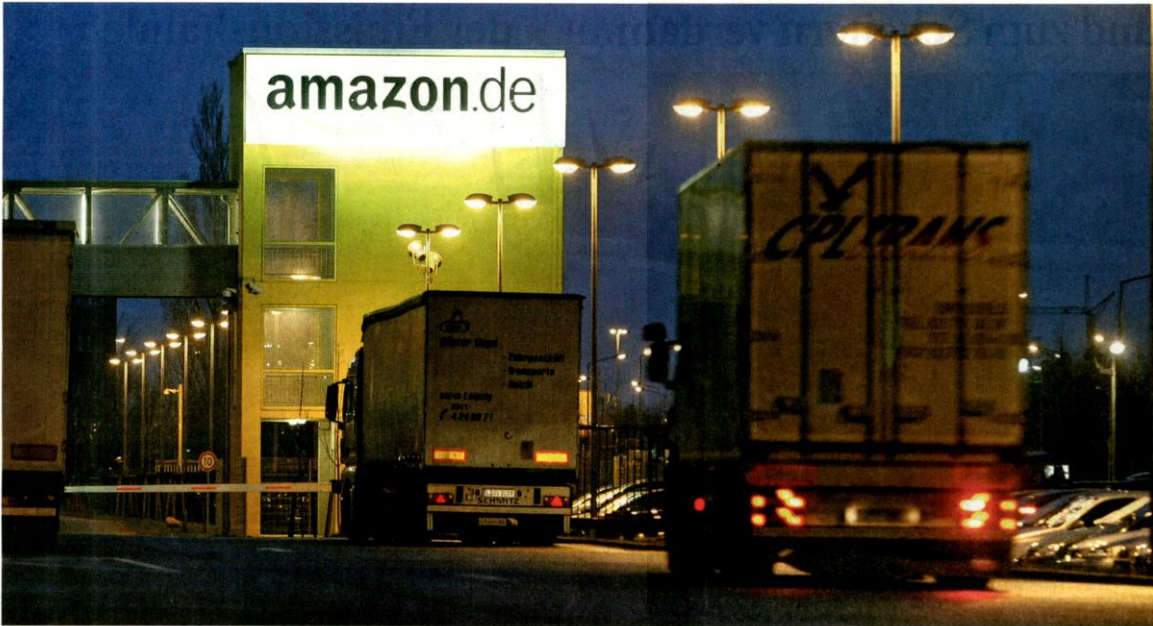
Abtraum für den stationären Einzelhandel: Das Vertriebszentrum des Internetversandhauses Amazon in Leipzig
